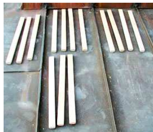
Foto 2: Vorheizen der Leisten auf einem Blechdach
