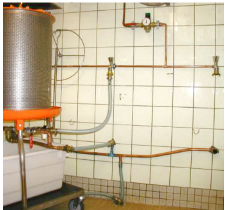
Foto 1: Pressstation mit 3 Pressplätzen
